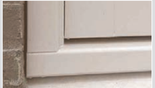
Kenmerkend voor het 3D COMBI-Kozijn: beluchting tussen metselwerk en kozijn.
